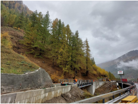
Neben der Furabrücke wird eine provisorische Umfahrungsstrasse samt Hilfsbrücke erbaut. Quelle: Interalp Bau AG
